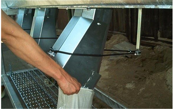
Abbildung 9: Befüllen des Sandsacks
