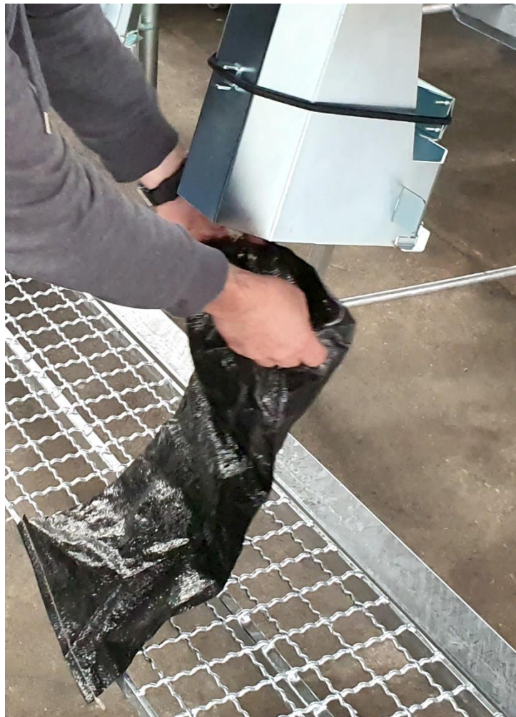
Abbildung 8: Stülpen eines Sandsacks über ein Auslaufrohr
